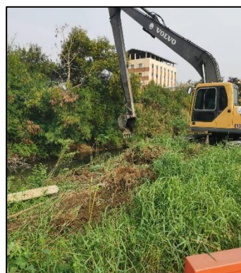
รูปที่ 2-11 การขุดลอกคูระบายน้ำภายในโครงการ
