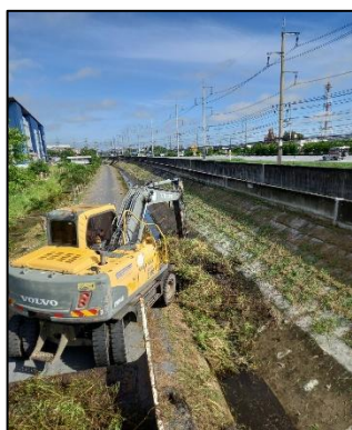
รูปที่ 2-11 การขุดลอกคูระบายน้ำภายในโครงการ
